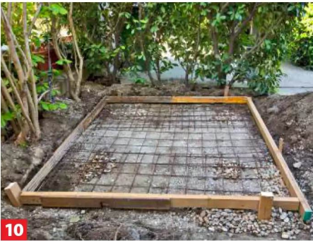
10 Sie sollten zunächst eine PE-Folie in die Schalung legen und dann den Rahmen etwa zur Hälfte mit Beton füllen.
