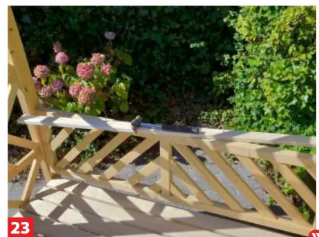
23 Befestigen Sie die Abdeckleiste O oben auf der Rückseite mit Schrauben 4,0 x 40 mm.
