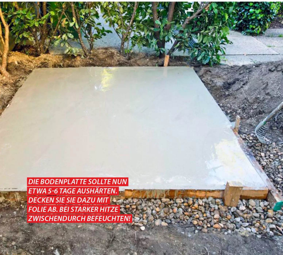
13 Den Beton durch Stochern verdichten – so können Luftblasen entweichen. Dann bis zum Schalungsrand auffüllen.
