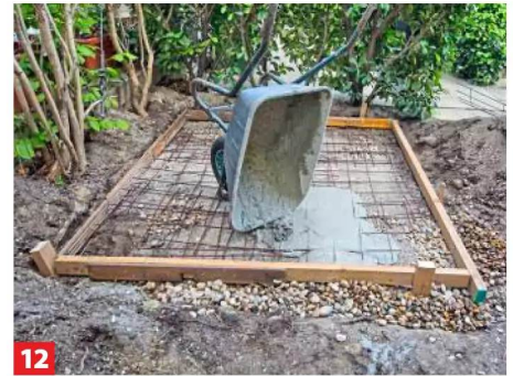
12 ... und beim Mischen von Hand immer den Beton ins Wasser geben. Hier ist der Beton etwas zu dünn geraten.
