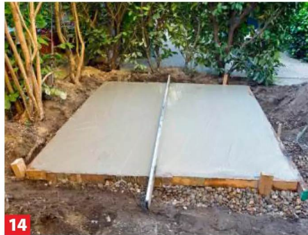
14 Mit einer langen Abziehlatte ziehen Sie die Platte glatt über die Schalung ab – dabei die Latte immer leicht hin und ...
