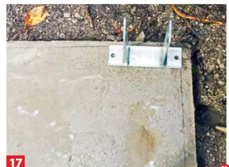
17 Wichtig: Die Dübel und Bohrungen dürfen nicht zu nah am Rand liegen, sonst kann der Beton abplatzen!
