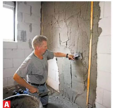
5 Zwischen den Leisten trägt man nun mit einer Glättkelle den Grundputz auf.
