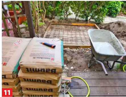
11 Erst dann werden die Stahlmatten eingelegt. Verwenden Sie Estrichbeton. Die empfohlene Wassermenge beachten ...
