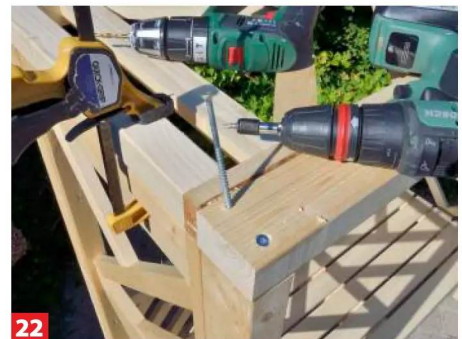
22 Heben Sie die Bank an und schrauben Sie das Dachspalier mit 5,0-x-80-mm-Schrauben gut fest.
