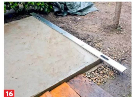
16 Nach dem Abbinden kann die Randschalung entfernt werden. Zeichnen Sie die Positionen für die Pfostenträger auf.
