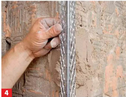
4 Über Eck setzt man Eckschienen/Putzeckprofile in Mörtel, sie schützen die Eckbereiche vor Beschädigungen.
