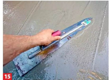
15 ... her bewegen. Ggf. mit einer Bodenleigerkelle nachglätten, wenn der Beton leicht anzieht.
