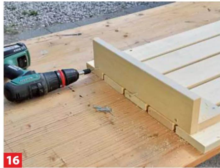
16 Es folgt die Sitzfläche. Schrauben Sie die acht Querstreben Q ...
