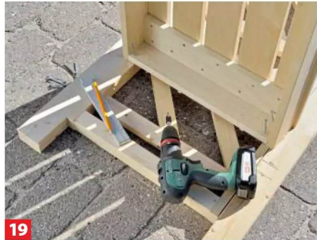
19 ... setzen Sie die Sitzfläche darauf. Kippen Sie diese etwas nach hinten und befestigen sie mit Schrauben 5,0 x 60 mm ...
