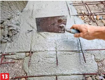
13 Den Beton durch Stochern verdichten – so können Luftblasen entweichen. Dann bis zum Schalungsrand auffüllen.
