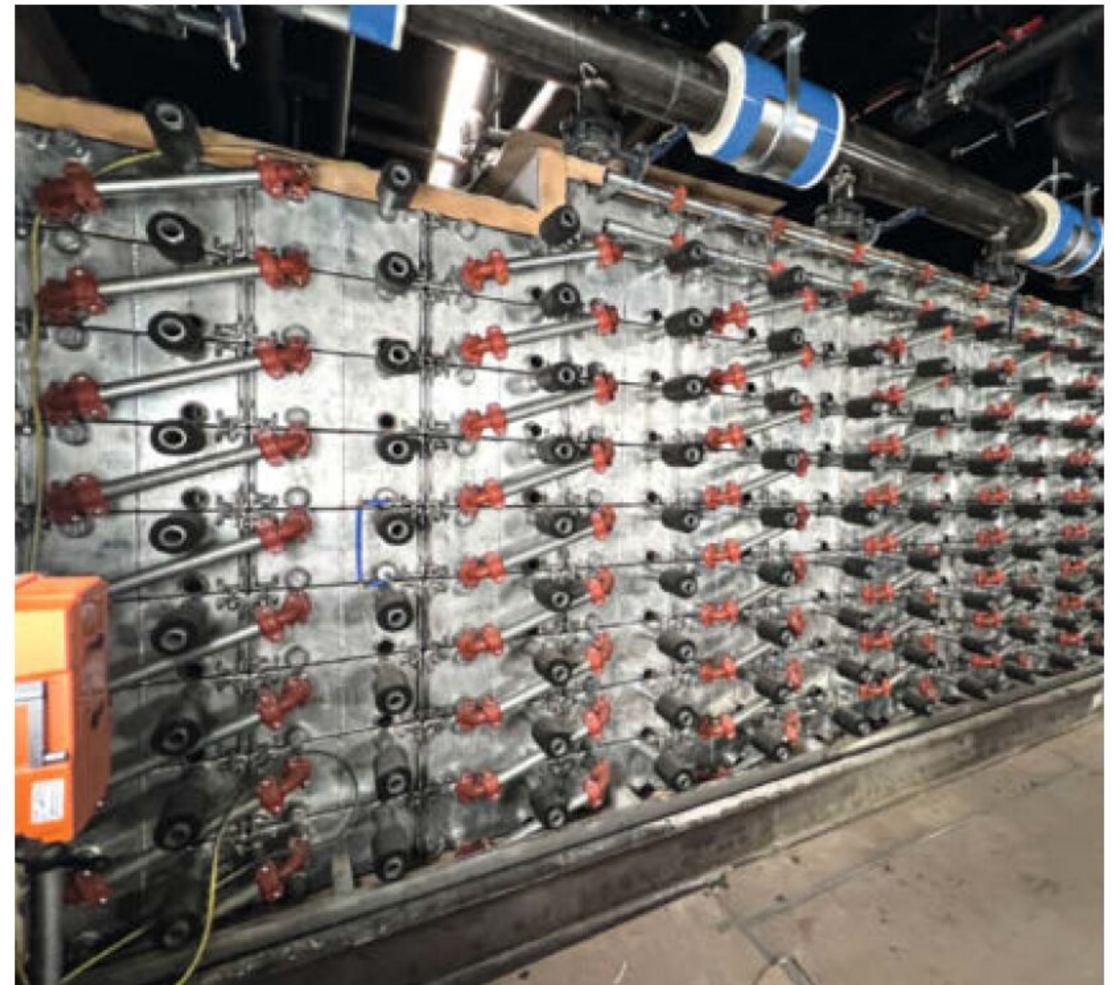
Der Eisspeicher von IceBrick – hier noch ohne Isolierung – soll die Netzbelastung reduzieren
