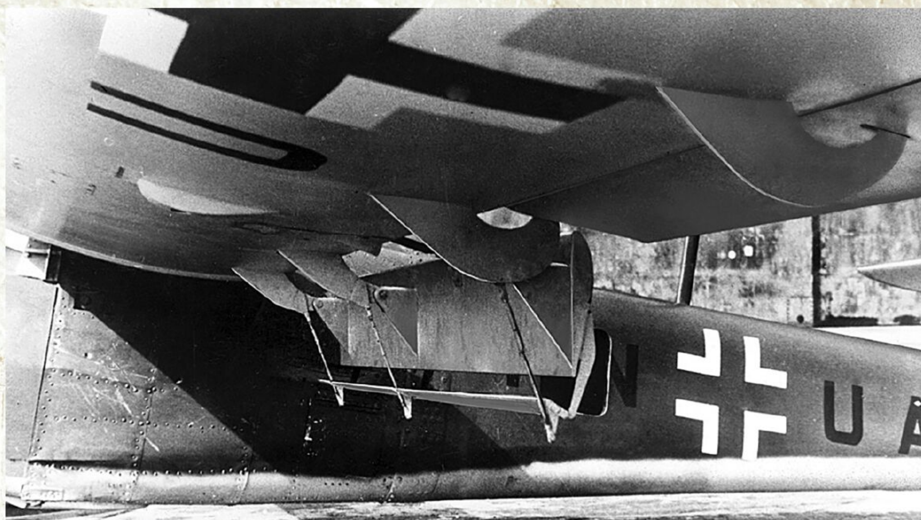
Die Landeklappe der BV 40 in voll ausgefahrener Stellung zur Gleitwinkel-Steuerung.
