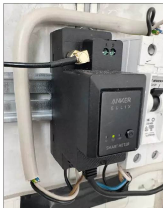
Den Anker Smart Meter installiert der Elektriker im Zählerschrank.
