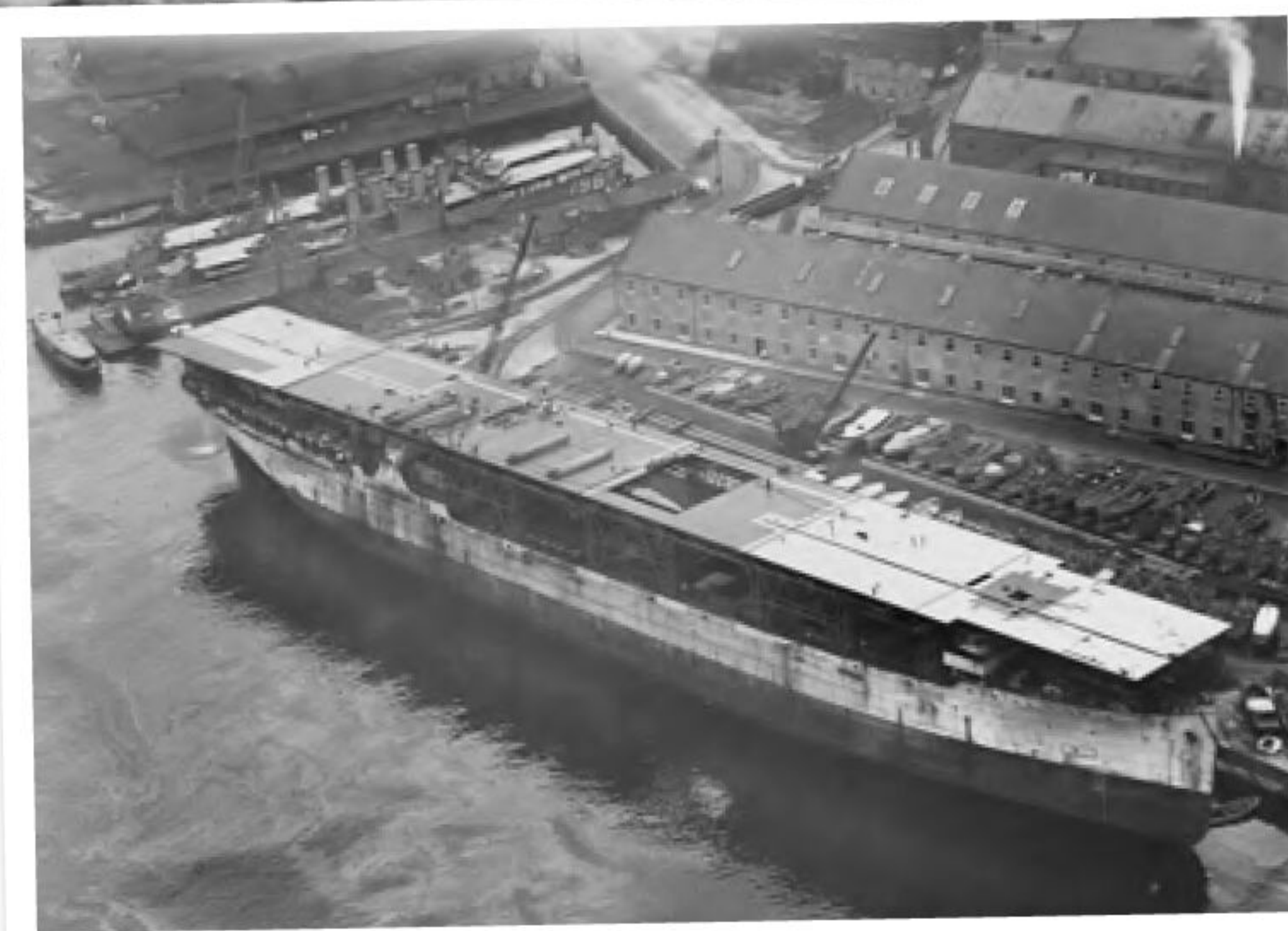
DER UMBAU: Ende 1921 entsteht auf der Norfolk Naval Shipyard, Virginia, aus dem ehemaligen Kohlenschiff der Flugzeugträger
